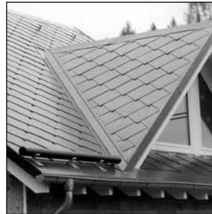
Dachgaube mit Kehlusbildung
