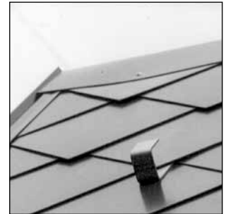
Dachfirst mit Abdeckung
