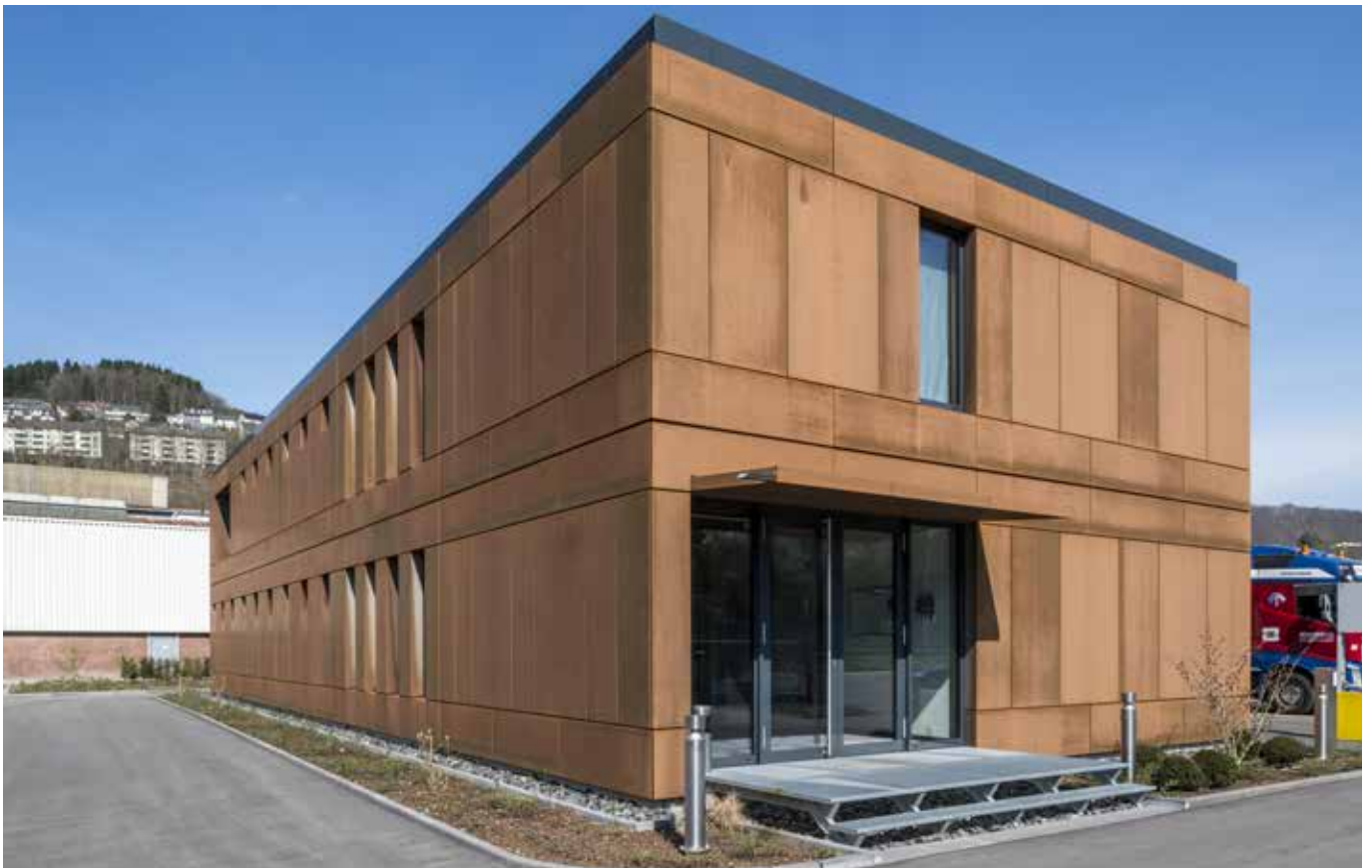
■ oben: Metallinnung, Garching unten: Verw.-Gebäude Menshen, Werdohl
