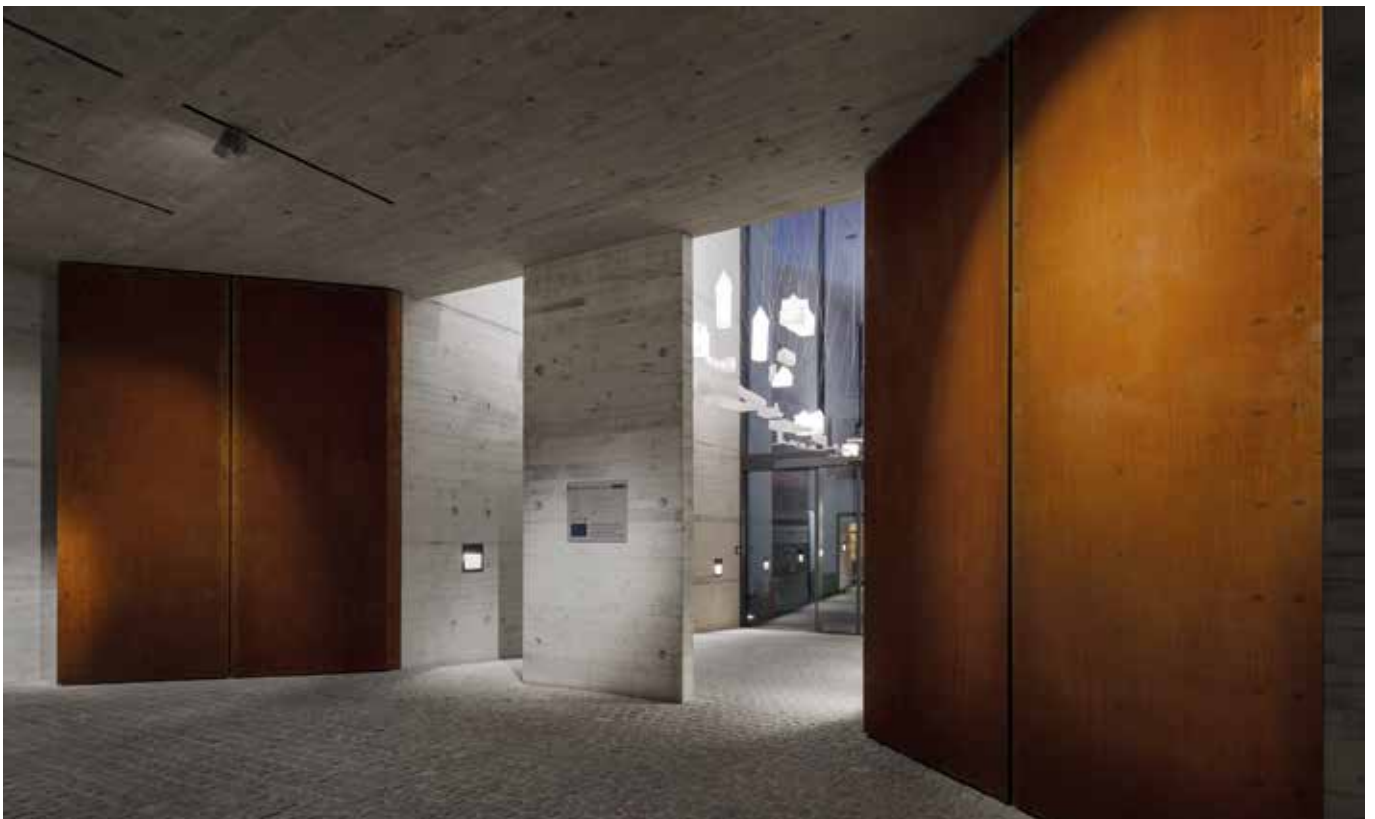
■ Aufzug Burg Altena Wandverkleidung Cortenstahl, werkseitig bewittert
