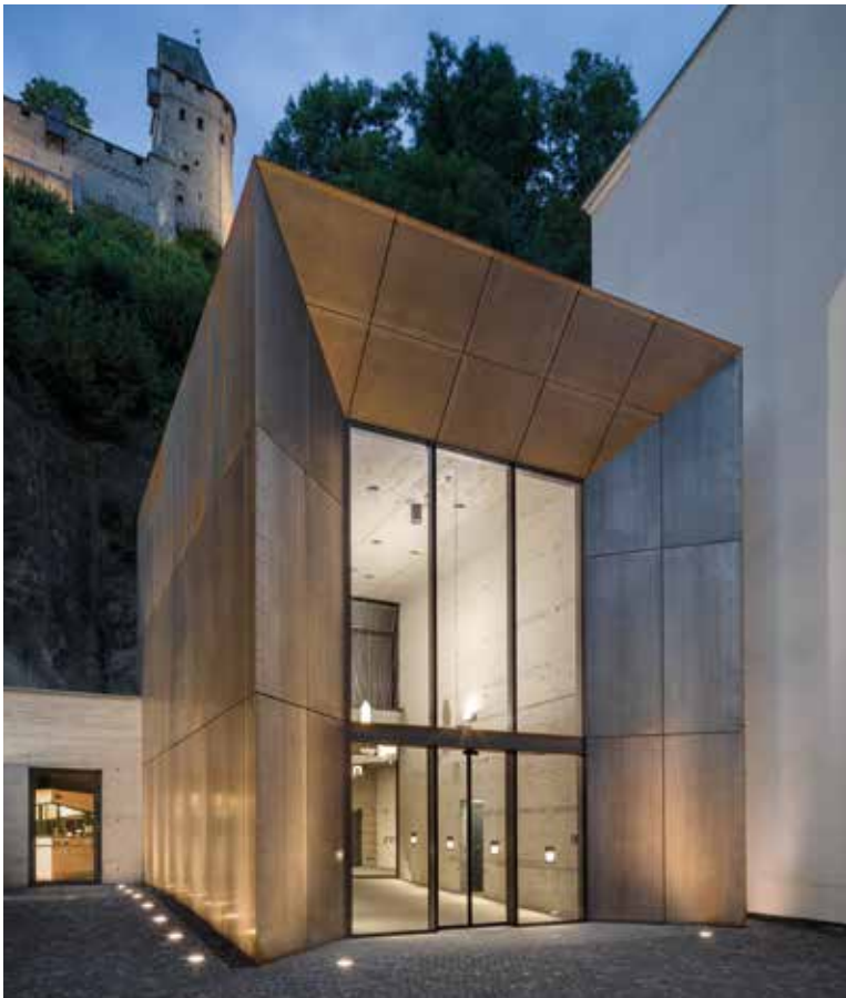
■ Aufzug Burg Altena Cortenstahl Natur
