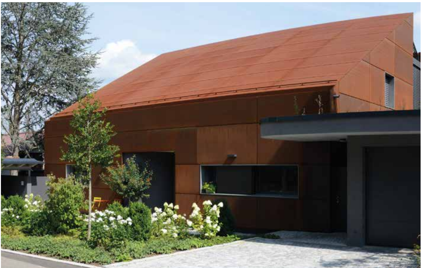
■ Wohngebäude Schmiege oben: ohne Vorbewitterung, unten: nach 2 Jahren Naturbewitterung
