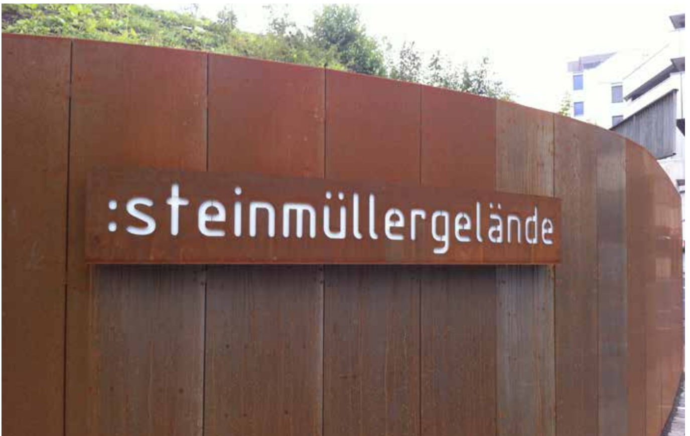
■ Querung Vogtei, Gummersbach Mauerscheibenverkleidung, naturbewittert
