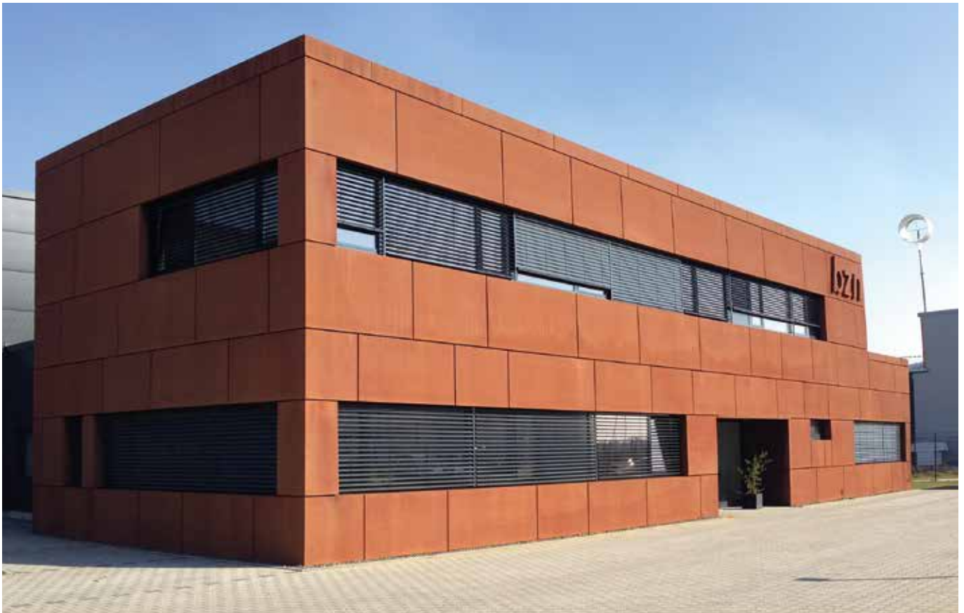
■ Büro- und Lagergebäude Neuss Wandverkleidung Cortenstahl, werkseitig bewittert
