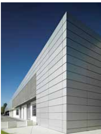
■ MAN Firmengebäude München Aluminiumfassade, Eloxiert E6/EV1
