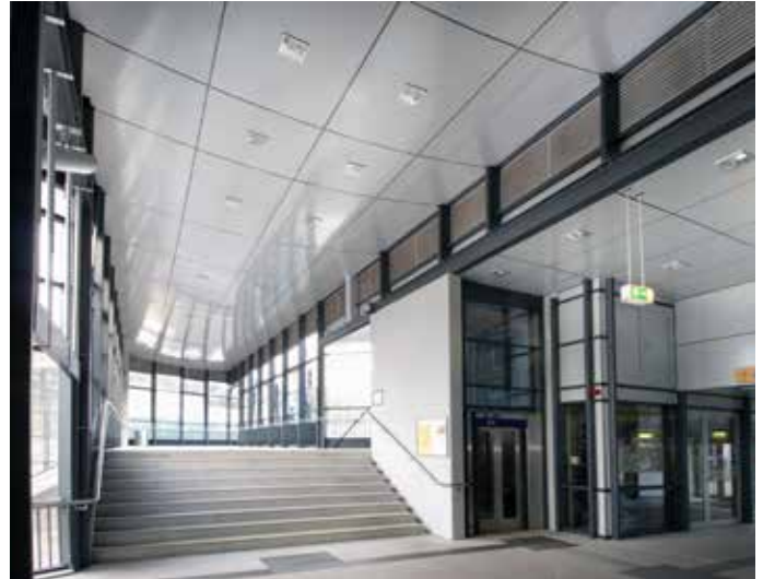
■ Bahnhof, Wissen Deckenverkleidung
