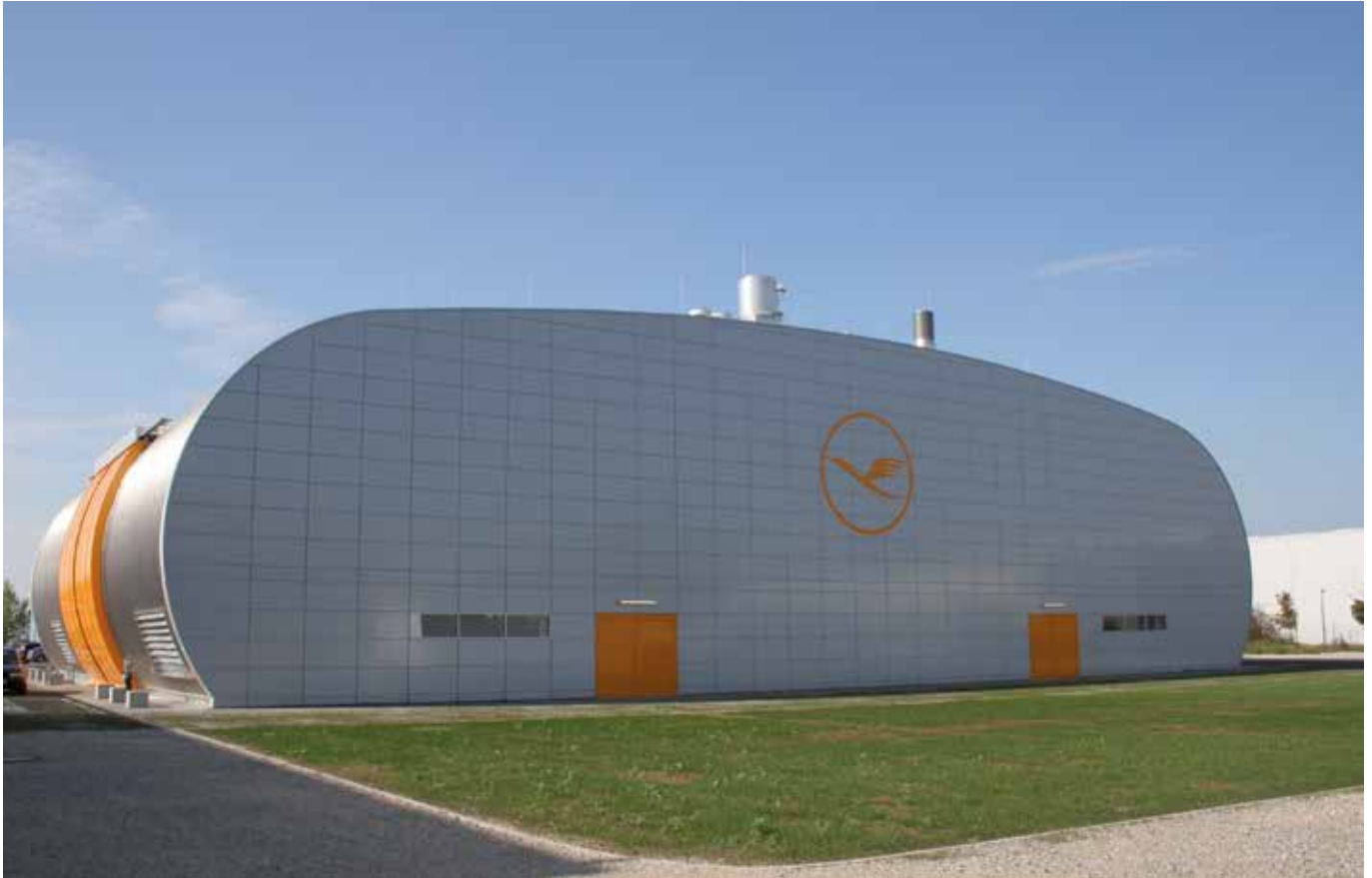
■ Lufthansa Flight-Training-Center, Wien Fassadenverkleidung dem gebogenen Wandverlauf angepasst, Aluminium, 3 mm, RAL 9006 pulverbeschichtet
