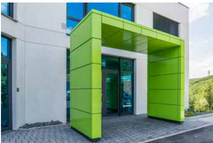
■ Schnee Fensterbau, Siegen Alu-Kassettenfassade, pulverbeschichtet
