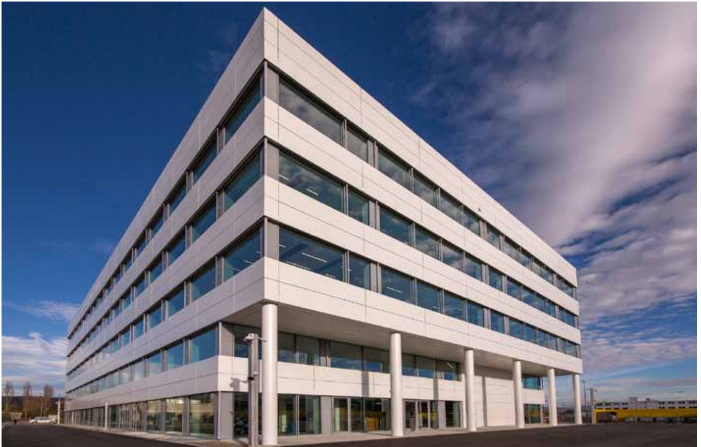
■ Lehlabor Hoffmann La Roche Kaiseraugst Kassettenfassade
