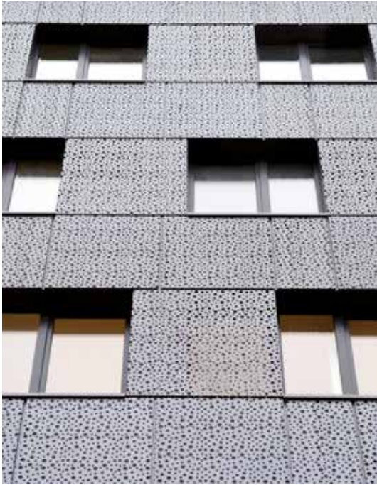
■ Q7, Mannheim Verkleidung mit verschiedenen Größen an Löchern in pulverbeschichtetes Aluminium gelasert
