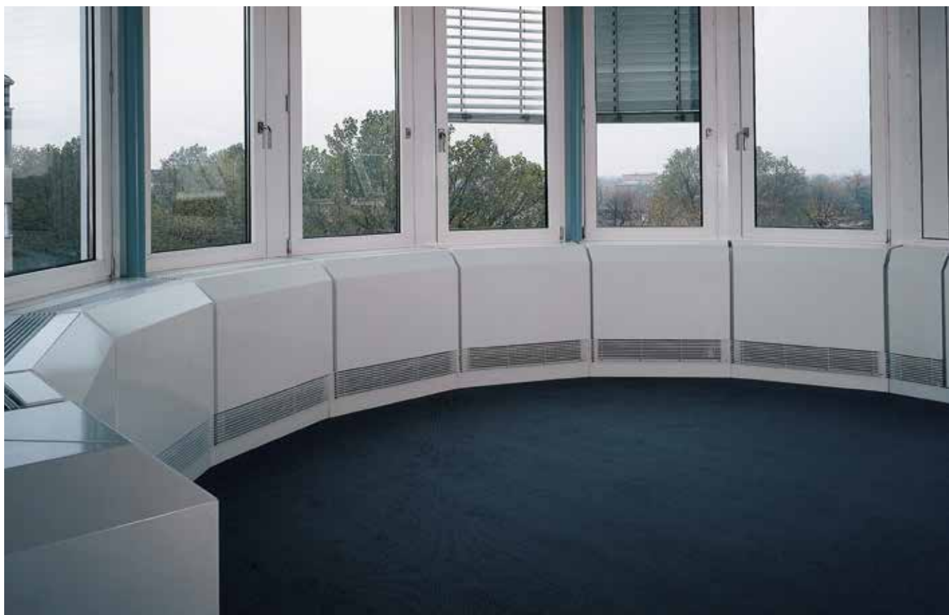
■ IBM Heidelberg Brüstungsverkleidung verzinktes Stahlblech, pulverbeschichtet
